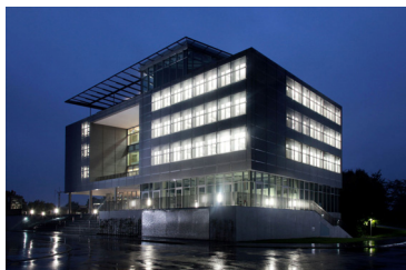
Bei Dunkelheit wird die Transparenz der Fassade besonders deutlich.
