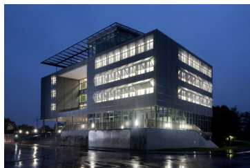
Die individuelle Nutzung der Faltläden erfolgt je nach Nutzerverhalten.
